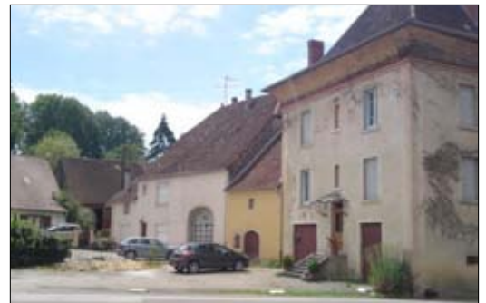
Les constructions ont des hauteurs différentes (rue Honoré Chapuis, rue des Levées)
