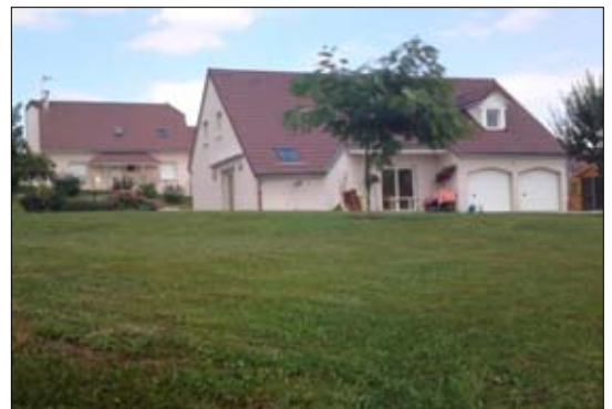
Les constructions sont généralement à R+C
