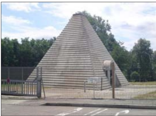
La chaufferie bois
