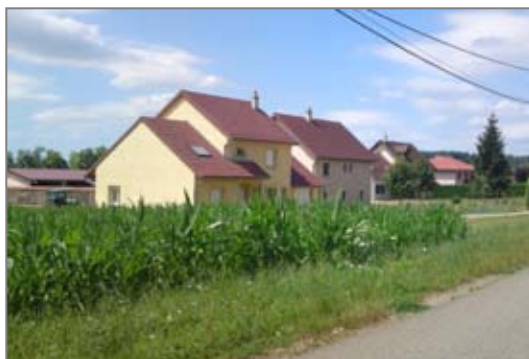
Nouvelle construction rue de Sous Bois
