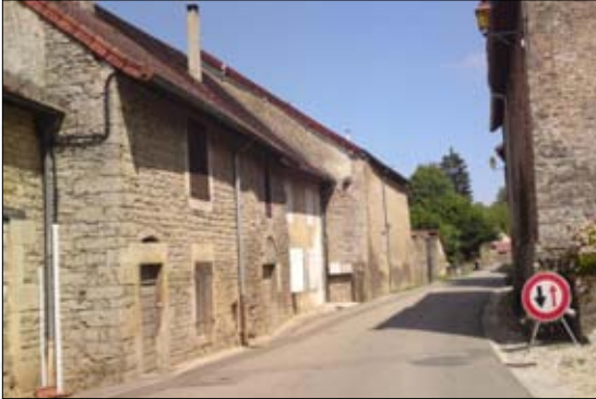
Front bâti continu dans le centre ancien (rue du Bourg Dessus)
