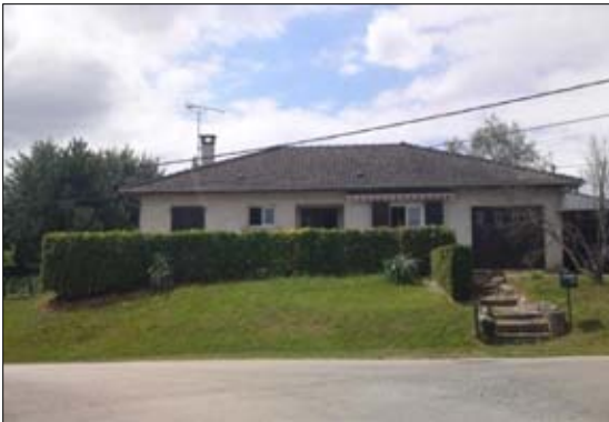
Quelques constructions se sont implantées sur des remblais
