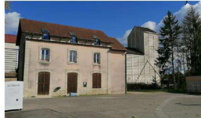
Figure 7 : Le bâtiment et le parvis de la gare (avril 2022)
