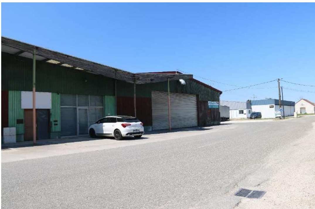
Le bâtiment est vieillissant et plus adapté aux normes actuelles, photographie prise le 30.06.2025
