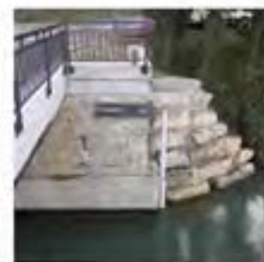
④ 395 000 € PONT DE TOULOUSE-LE-CHÂTEAU
